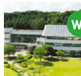
학생회관-1 W2 DDDN 피자, 서측 학생식당, 더큰도시락, 우리은행, 교내 매점, 여행사, 미용실, 새마을금고 등
